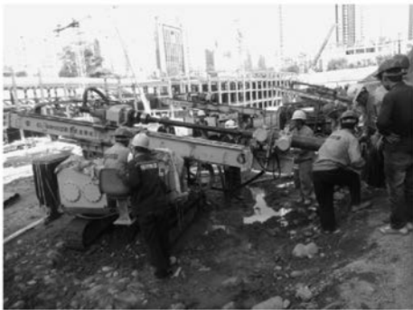
图 2 西宁旋锚施工现场
