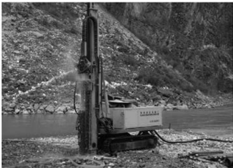
图 1 丹巴跟管钻进施工现场
