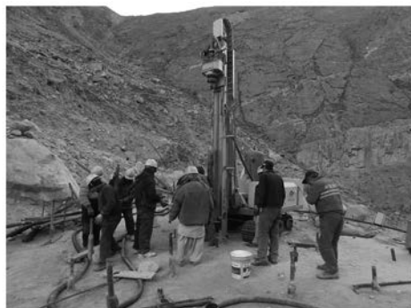
图8 GL-4000C型钻机在巴基斯坦施工现场
