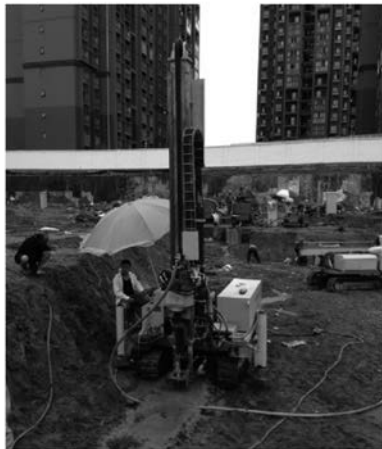
图 9 德阳旋喷施工现场
