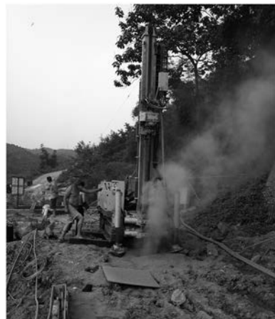
图 10 重庆跟管钻进施工现场
