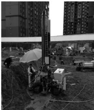
图9 德阳旋喷施工现场
