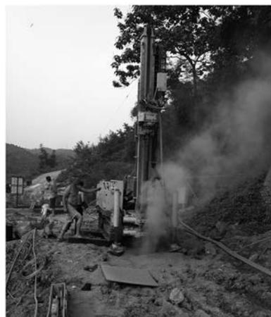
图10 重庆跟管钻进施工现场
