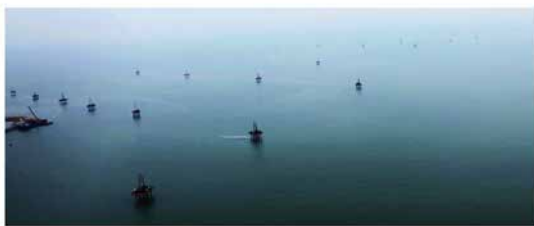
图8 莱州湾海上勘查施工项目全景
