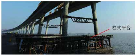
图3 杭州湾大桥施工使用的桩式平台
