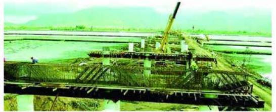
图5 盐州跨海大桥筑岛施工现场
