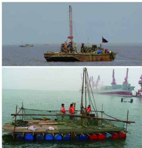
图6 用于工程地质勘察的浮式平台
