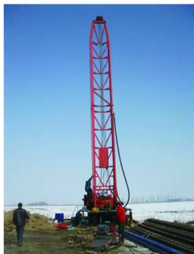
图 5 SPT-1500 型拖车钻机施工现场
