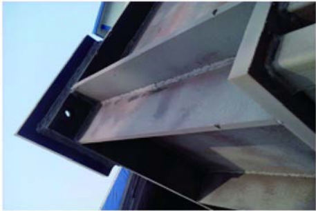
图 3 喷砂作业完成效果
