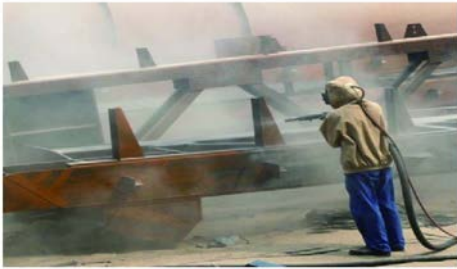
图 2 喷砂作业现场
