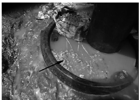
图5 钻进时上返的白色片状石英岩屑
