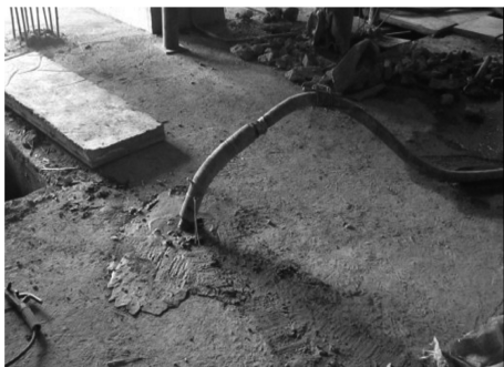
图1 钢管通长注浆法
