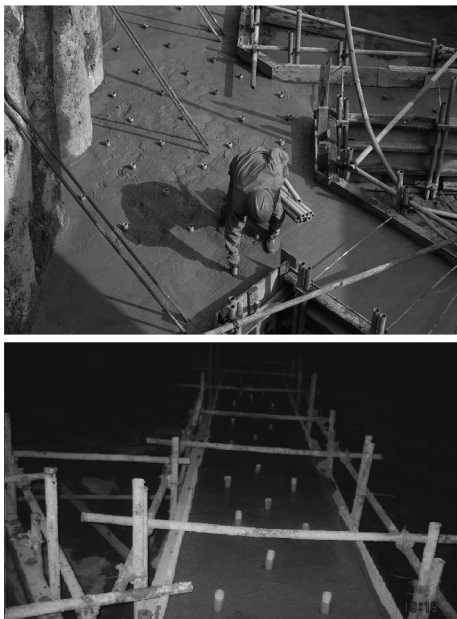
图 3 现场插管照片
