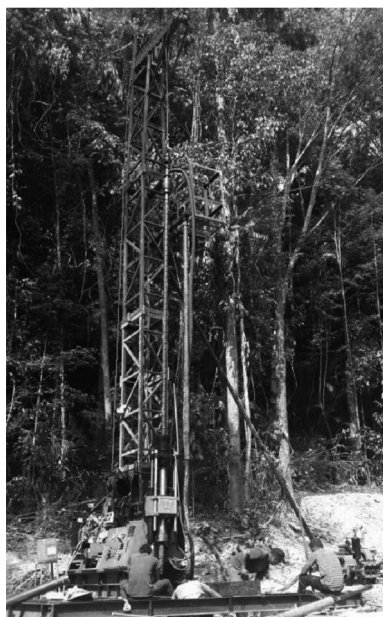
图5 马来西亚施工现场
