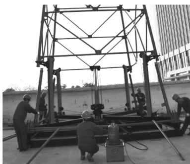
图4 顶升塔架后对接主腿
