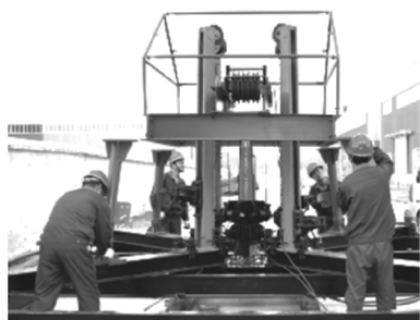
图3 安装顶主腿
