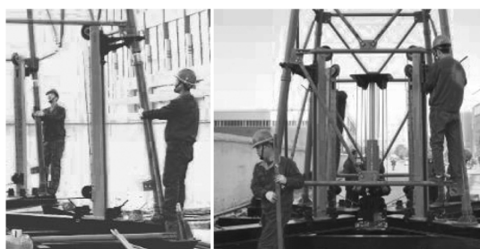
图5 安装连接杆
