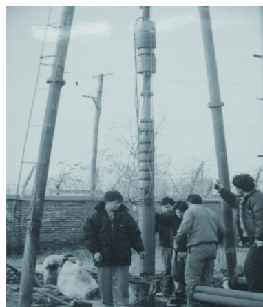
图5 潜水泵加封隔器
