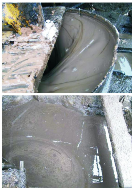
图4 现场配制泥浆
