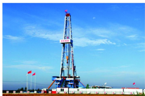
图 1 中国大陆科学钻探工程施工现场
