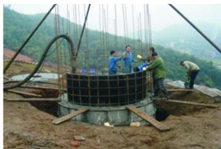
图3 沉井过程中其周边形成了坍塌区域
