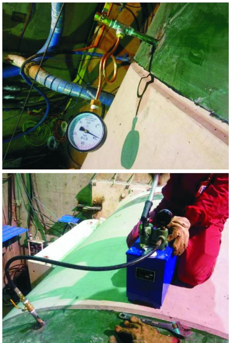
图 6 隧道管节修复装置耐压试验过程
