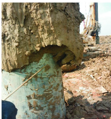
图3 护筒拔起后的外观
