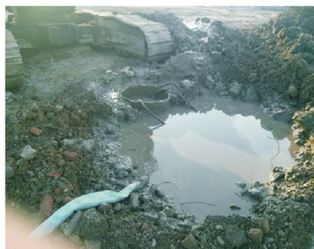
图4 孔口泥浆缓存围堰
