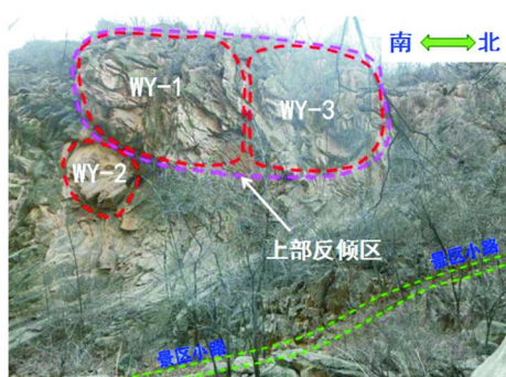
图 3 不倒翁景点附近崩塌地质灾害点危岩体近视图
