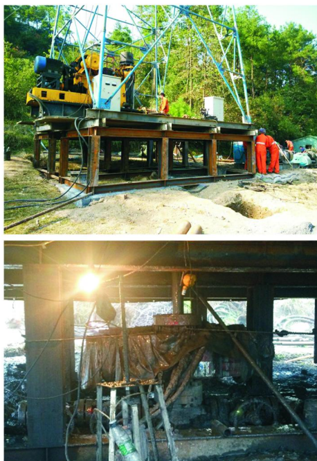
图 1 华地一井的钻塔基座现场照片
