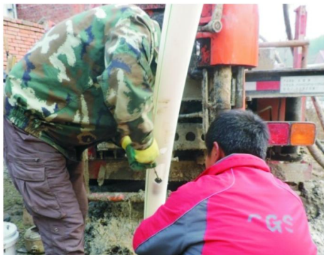
图7 监测窗口作排气孔
