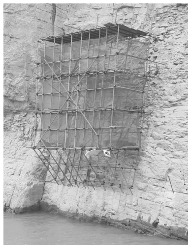
图2 脚手架钢管悬挑钻探平台
