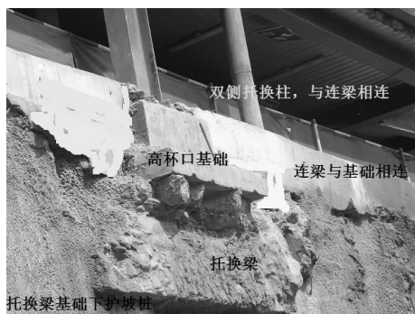
图3 托撑加固现场
