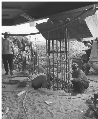
图 5 钢筋笼制作与下放现场
