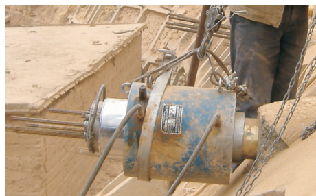
图5 多束千斤顶张拉
