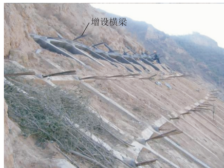
图3 锚索Ⅱ区锚索分布现状
