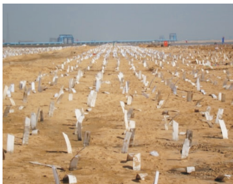
图7 塑料排水板施工情况
