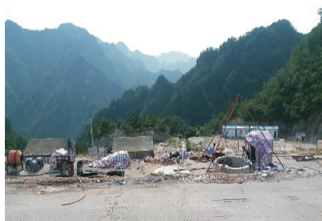
图10 城门峒1号副坝辐射井施工现场
