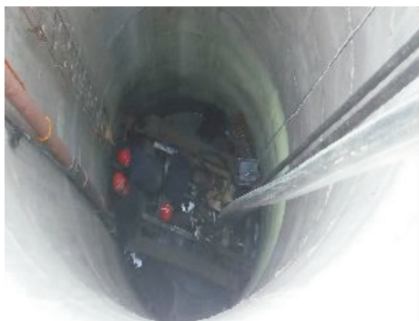
图4 辐射井井内施工照片
