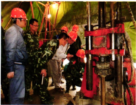
图 11 阳山金矿区 ZK2132 孔现场纠斜试验
