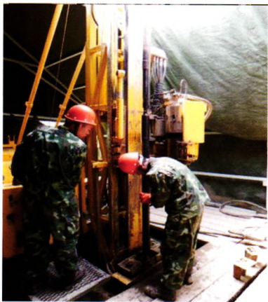
图 10 阳山金矿区 ZK0112 孔现场纠斜试验
