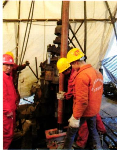
图 3 下套管 (下钻)
