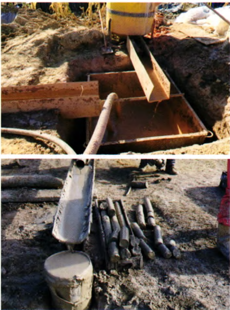
图 4 泥浆不落地措施
