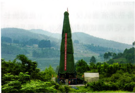
图 1 湘永地 1 井钻探施工现场
