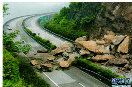
图1 渝黔高速崩塌(2014年4月28日)
