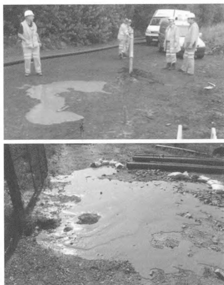
图2 非开挖 HDD“溢浆”现象
