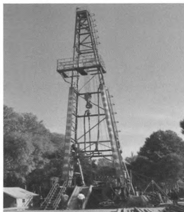
图 1 BSZ3200 型钻机施工现场
