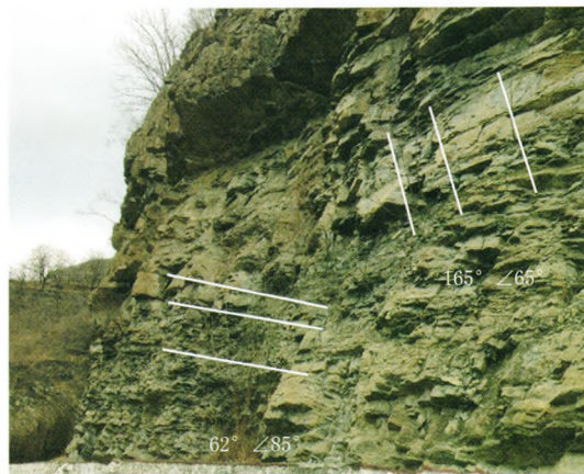
图 12 K4+555~570 段边坡结构图
