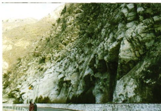
图4 贾金路地灾治理段区域地貌现状
