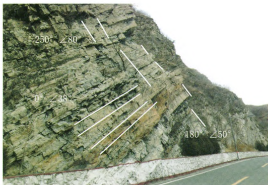
图 10 K4+435~490 段边坡结构图
