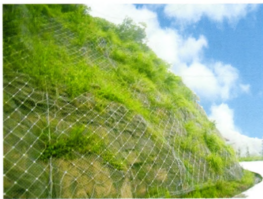
图18 治理区域现场工况图
