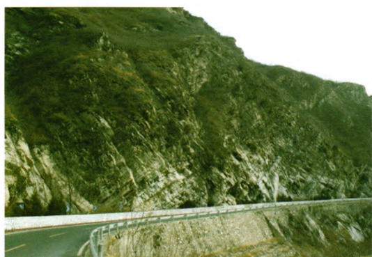
图3 贾金路地灾治理段区域地貌现状
