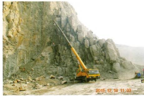
图 4 裂隙勾缝注浆
