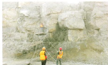
图 5 坡面喷面
