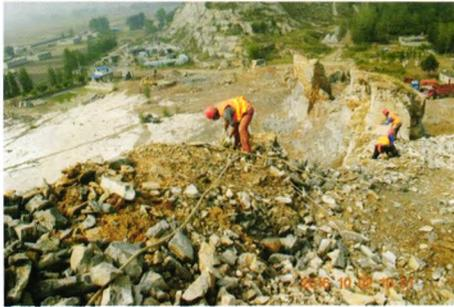
图 2 坡顶削坡排险施工
