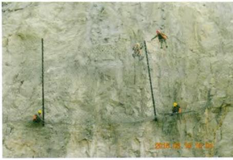
图 7 被动防护网施工
