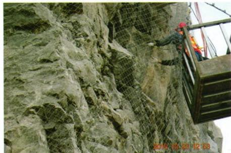
图6 主动防护网施工
