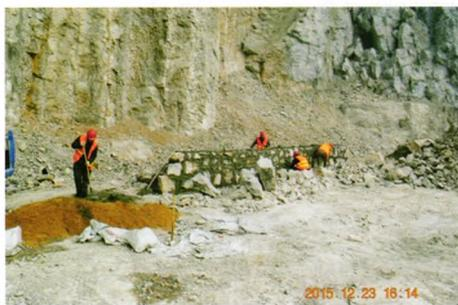
图8 挡石墙砌筑
