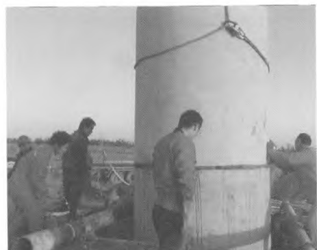
图 4 下水泥护筒图
