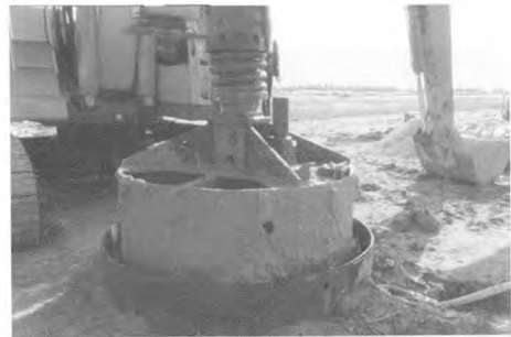
图 3 集水井施工图
