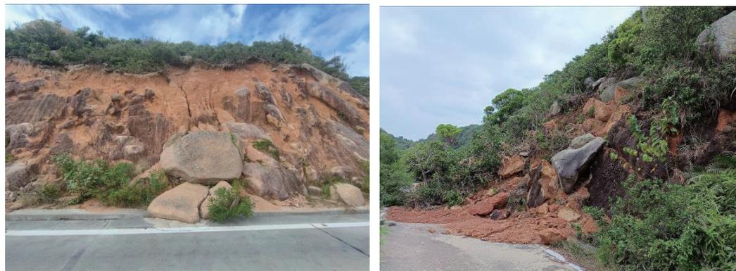
图 13 牵引-滑移式崩塌现场照片
