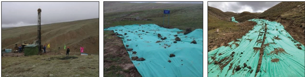
(a) 未治理的钻机平台 (b) 探槽治理 (c) 道路治理
