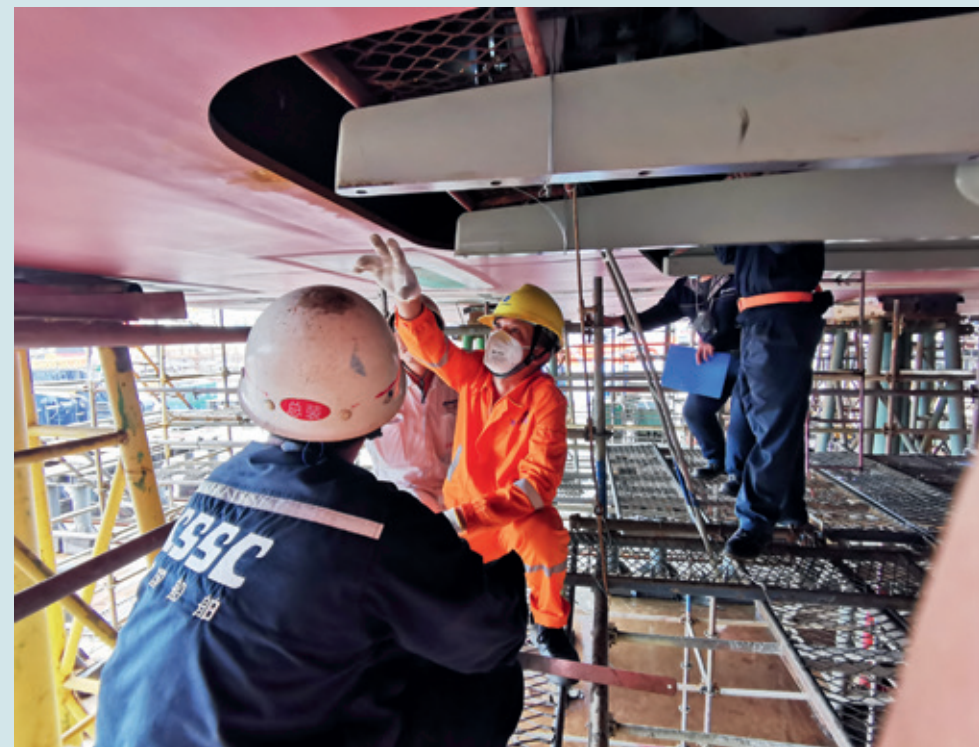
> 检验全回转伸缩推进器底板安装
