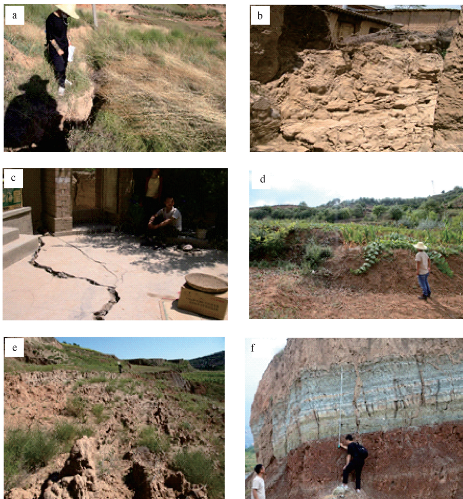
a~f.黎坪村滑坡发育特征现场照片;a.滑坡体后缘拉裂缝,镜向 NE;b.地震时倒塌的外墙,镜向 NW;c.滑坡体中部居民家地面裂缝,镜向 NE;d.滑坡体中部的垂向位错陡坎,镜向 W;e.滑坡体前缘黄土溜滑,镜向 NW;f.滑体侧缘地层剖面,镜向 NW
