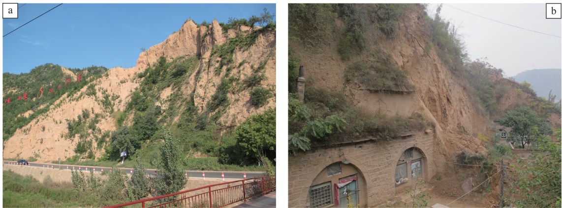
图2 吉县城区公路边坡滑塌(a)和土窑边坡崩塌(b)
