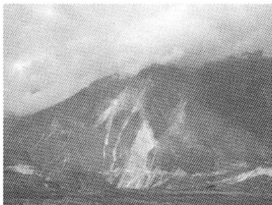
图6 香格里拉县滑石板滑坡(镜像SW)
