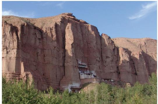
图4 易于发生倾倒—拉裂的红砂岩塔状危岩
