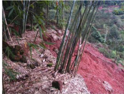
(b) 陡坡上覆崩坡积堆积体滑动
