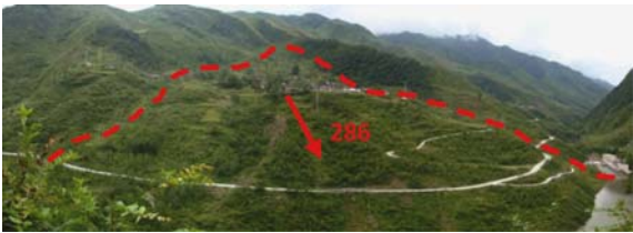
图 2 峨边县勒乌热罗滑坡影像 Fig. 2 Image of Lewureluo landslide
