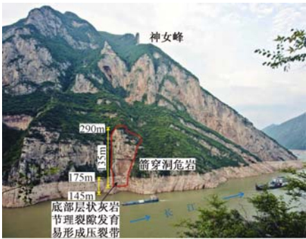
图 3 重庆巫峡箭穿洞危岩体 Fig. 3 Jianchuandong unstable rock mass in Wuxia, Chongqing
