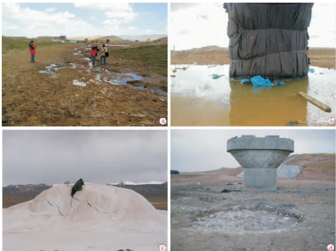
图8 乌丽85道班DK1202+668铁路大桥中部桥墩施工诱发泉水及工程防治效果
