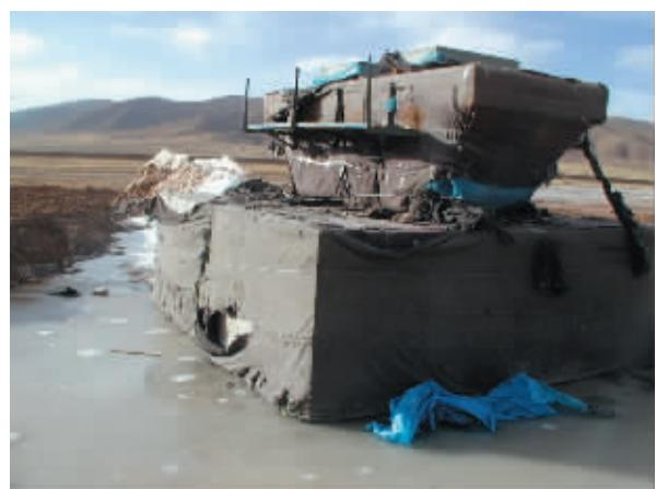
图5 雅玛尔河南侧SEF北分支断裂破碎带铁路桥基施工诱发移动冰丘(摄于2004年3月,镜头向西)
