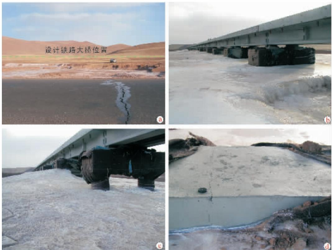
图4 青藏公路83道班东侧SEF南分支断层破碎带桥基施工诱发移动冰丘及灾害效应
