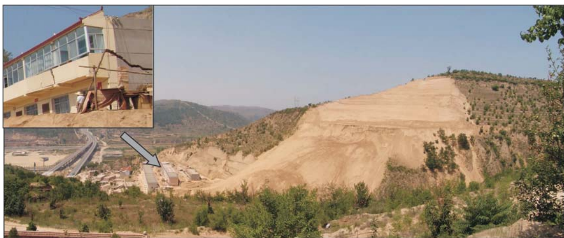
图5 2006年6月15日发生的新滑坡全貌
