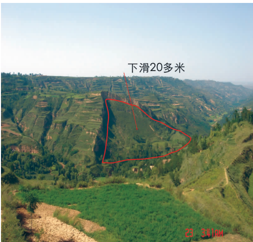
图 6 瘠背梁滑坡 Fig. 6 Jibeiliang landslide
