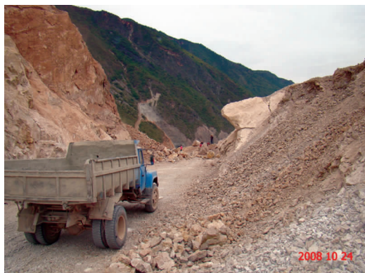
f.灰岩崩塌阻塞交通(镜向 1750°)
