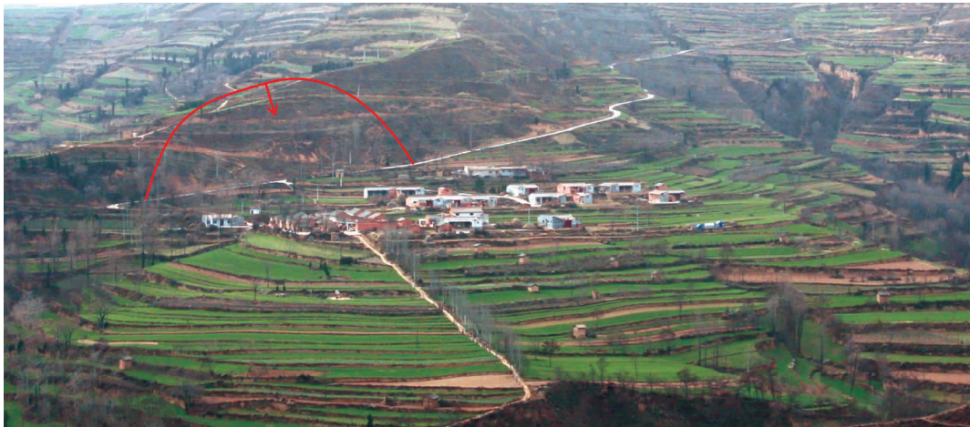
图 2 吴家沟滑坡照片
