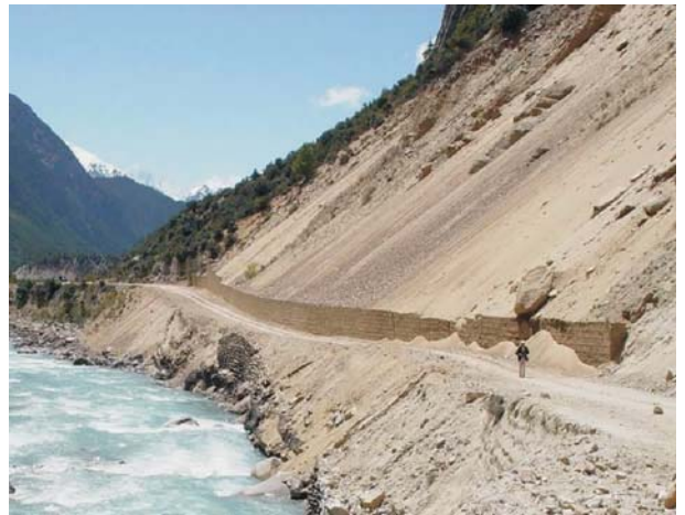
图 1 川藏公路中坝段溜砂坡的危害
