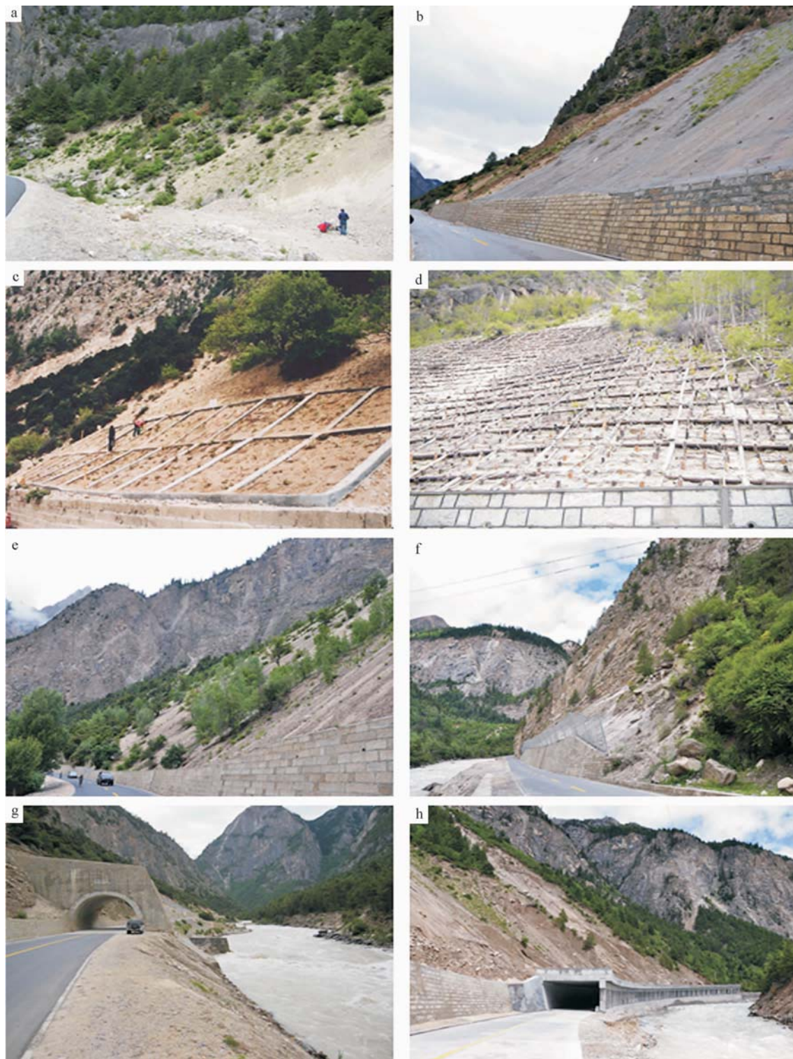
a.公路内侧预留溜砂堆积空间;b.川藏公路中坝段溜砂坡的 SNS 主动防护网工程;c.川藏公路中坝段溜砂坡框架锚杆植被固砂技术试验;d.川藏公路中坝段溜砂坡木桩排网植坡固砂工程;e.川藏公路中坝段溜砂坡防治工程—拦砂墙;f.川藏公路中坝段溜砂坡防治工程—SNS 被动防护网图;g.川藏公路中坝段溜砂坡防治工程—排砂渡槽;h.川藏公路中坝段溜砂坡防治工程—排砂棚网
