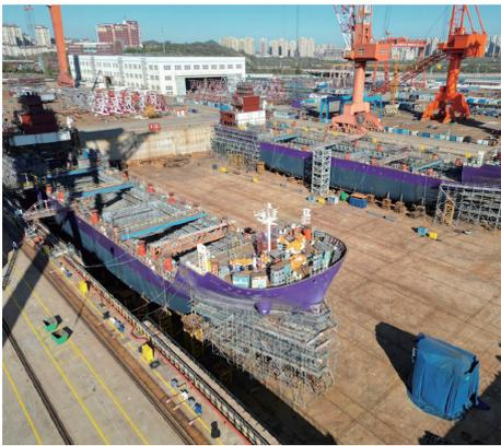
图5 正在建造的2艘液态二氧化碳运输船<sup>[5]</sup>
