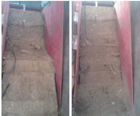
图2 开挖过程中和开挖完成后
